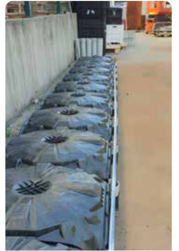
Düzenli aralıklarla kubbe, taban, kılavuz ve ayaklardan oluşan komple sistemin uzunluk kontrolü yapılır.
