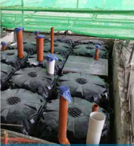
Düşük Döşeme Dolgusu Sunken Slab Filling
