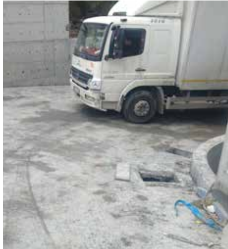
Otopark Rampası Yapımı Car Park Ramp Construction
