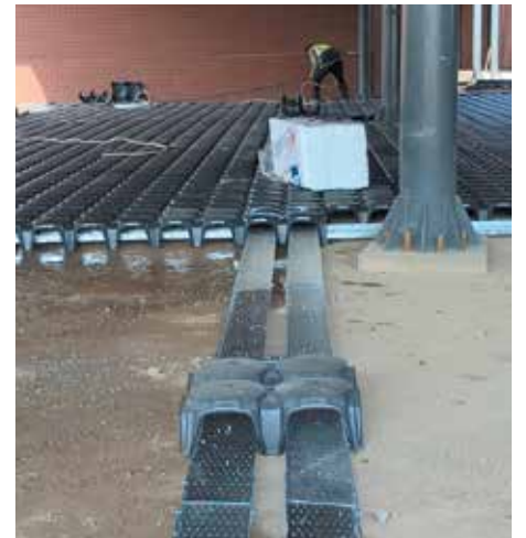
Betonarme Yükseltilmiş Döşeme Reinforced Concrete Raised Floor
