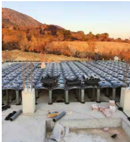
Subasman Yapımı Crawl Space Construction
