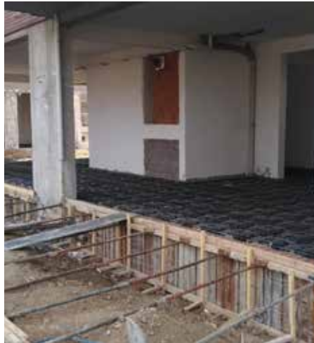
Subasman Yapımı Crawl Space Construction
