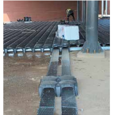
Betonarme Yükseltilmiş Döşeme Reinforced Concrete Raised Floor
