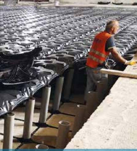
Düşük Döşeme Dolgusu Sunken Slab Filling
