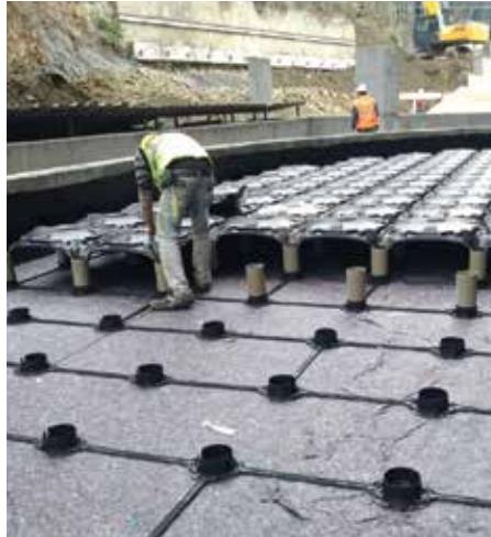
Otopark Rampası Carpark Ramp
