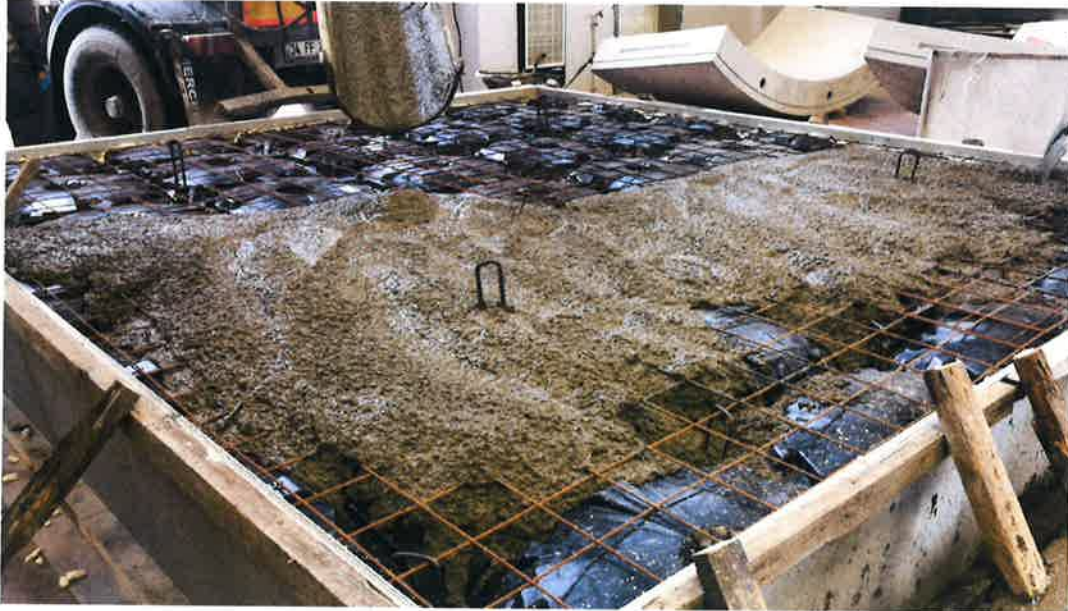
Şekil 3. Beton dökülürken
