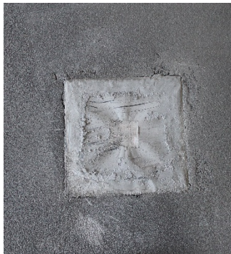
Beton dökümü sonrası priz kutusu betonarme yüzey ile bir yüz olacaktır.
