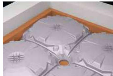
6. PVC boruların duvarlara bitişik olduğu tam kubbeli duvar bitişlerinde, boruların üzerine ABS Plus kubbe kenar kapama veya 5x10 ahşap takoz koyarak boşlukları aşağıya beton sızdırmayacak şekilde kapatın.
