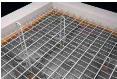
7. Beton sızdırmazlığı sağlanmış kalıpların üzerine projeye uygun cinsteki hasır çeliği ve PVC boruların içine dikey donatıları yerleştirin.
