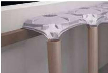
5. Son sıra kubbelerin yerleştirilmesi: Örnek 2; duvara bağlı ahşap konsol üzerine kubbenin kesilerek yerleştirilmesi.
