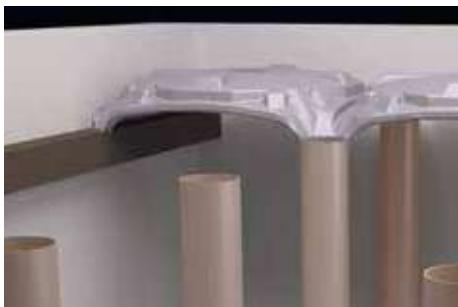
4. Son sıra ABS PLUS kubbelerin yerleştirilmesi: Örnek 1; duvara bağlı ahşap konsol üzerine tam kubbe.
