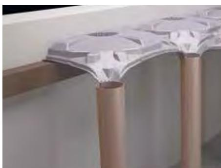
5. Son sırada kubbelerin yerleştirilmesi: Örnek 2; duvara bağlı ahşap konsol üzerine kubbenin kesilerek yerleştirilmesi.
