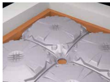
6. PVC boruların duvarlara bitişik olduğu tam kubbeli duvar bitişlerinde, boruların üzerine polistiren köpük veya 5x10 ahşap takoz koyarak boşlukları aşağıya beton sızdırmayaçak şekilde kapatın.
