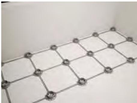
1. Tabanların düz taraflarını duvara bitişik olacak şekilde kılavuzları kullanarak yerleştirin. Duvarın köşesine gelen tabanı keserek tam köşeye oturtun.
