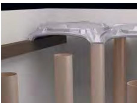
4. Son sırada ABS PLUS kubbelerin yerleştirilmesi: Örnek 1; duvara bağlı ahşap konsol üzerine tam kubbe.
